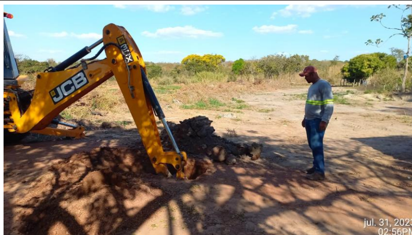
Coleta dos furos de sondagem
