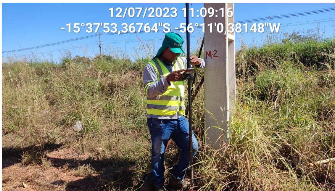
Levantamento da equipe de Topografia em campo – Implantação do M2
