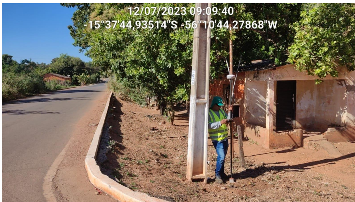
Levantamento da equipe de Topografia em campo – Implantação do M1
